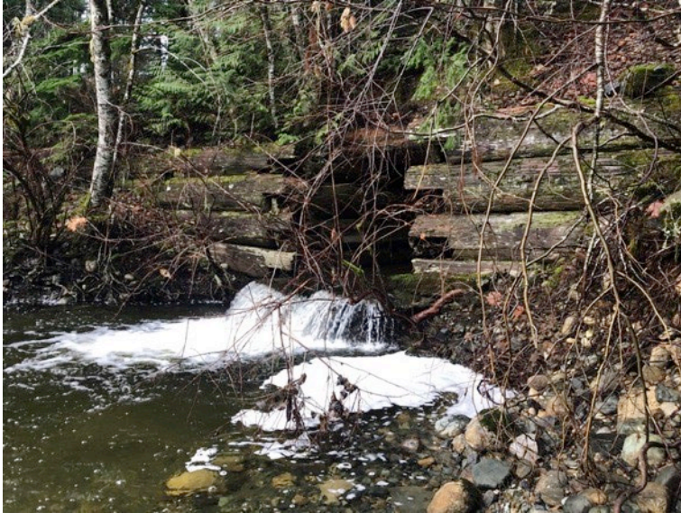
1.) Wolf Creek culvert
